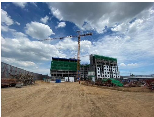
รูปที่ 47 Mesh Sheet คลุมอาคาร
