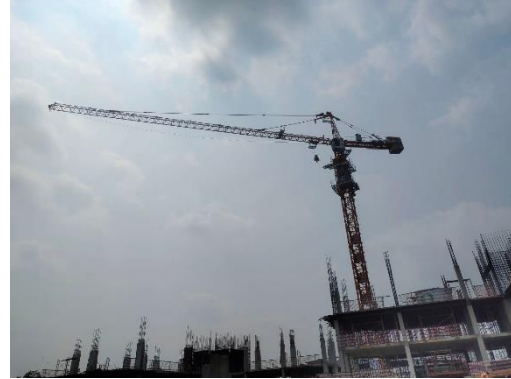
รูปที่ 24 ควบคุมการกวาดแขน (Boom) ของเครนให้อยู่ ภายในพื้นที่โครงการ
