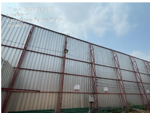
รูปที่ 1 รั้วชั่วคราวเป็นรั้ว Metal Sheet สูง 6 เมตร
