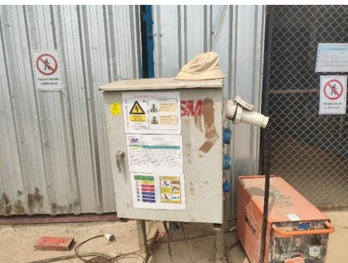
รูปที่ 44 ตู้ไฟฟ้าชั่วคราว และเจ้าหน้าที่ดูแลรับผิดชอบ
